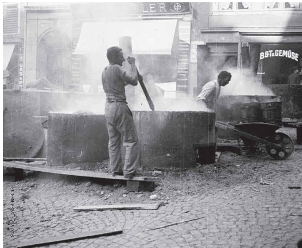
1933: Baustelle im Zürcher Niederdorf.
